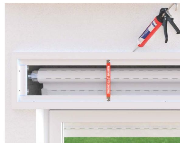
4 sigillare lungo il perimetro
