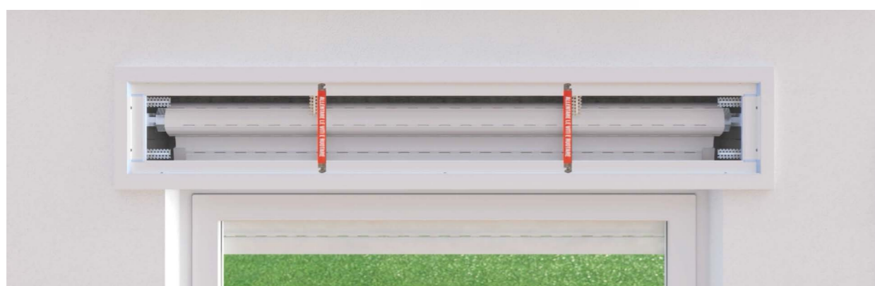
2 posizionare il cassetto sul vano predisposto per l'alloggiamento dell'avvolgibile dopo aver asportato il tappo riposizionando i fermi in verticale, inserire il cassetto
