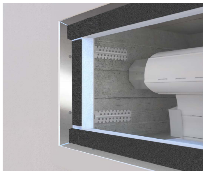
2 posizionare il cassonetto sul vano predisposto per l'alloggiamento dell'avvolgibile dopo aver asportato il tappo interno riposizionando i fermi in verticale, inserire il cassonetto
